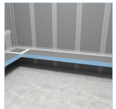
Übergänge und Stöße mit Armierband versehen. Bei der Anwendung im Dampfbad wedi Tools Dichtband und Epoxidharzfliesenkleber verwenden.
