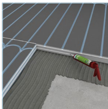
Abdichtung der Stoßbereiche
