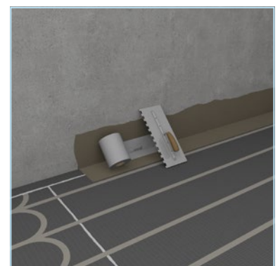
Abdichtung von Wand und Boden
