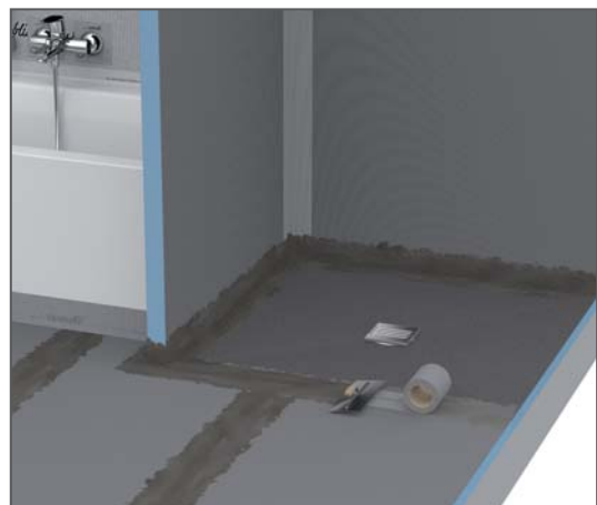
Afbeelding 12: afdichting van stuikverbindingen bij wedi bouwplaten onderling en naar het wedi Fundo douche-element met wedi Tools afdichtingsband bij W2-I
