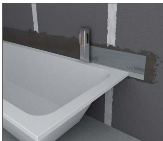
Afbeelding 4: aansluiting van de badkuiprand op de afdichtingslaag met wedi Tools butyl-afdichtband voor badkuipen
