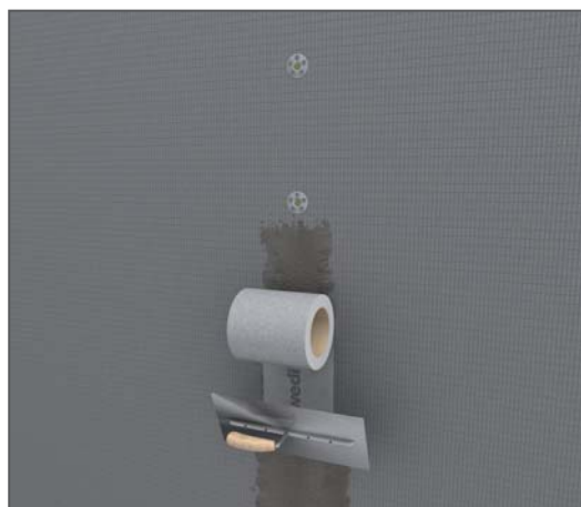
Afbeelding 8: afdichting van doorvoeren en voegen met wedi Tools afdichtingsband
