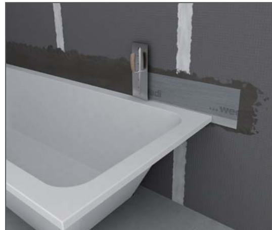
Abbildung 4: Anschließen des Wannenrandes an die Abdichtungsschicht mit wedi Tools Butyl-Wannendichtband
