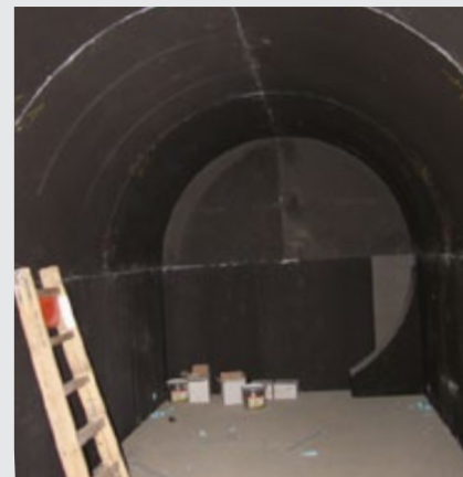
Vorher und Nachher der „Entspannungsröhre“
